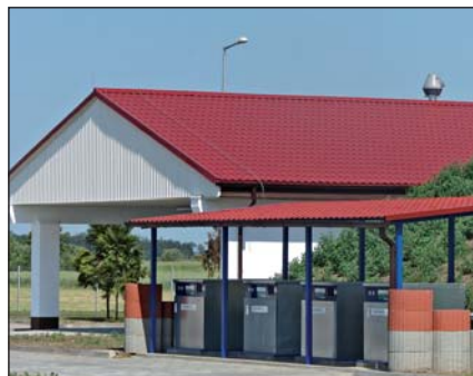
Oczyszczalnia ścieków w Miejskiej Górze.
