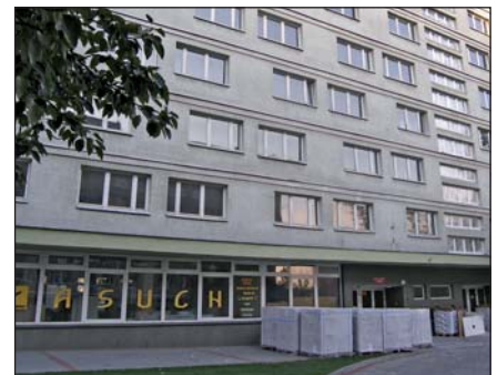
Termomodernizacja DS „Zbyszko” w Poznaniu.
