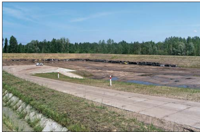
Składowisko odpadów niebezpiecznych w Koninie.
