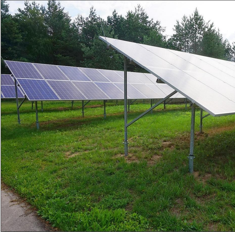
Przykład: Farma Fotowoltaiczna przy GWDA sp. z o.o. o mocy zainstalowanej 40 kWp składa się ze 160 paneli
